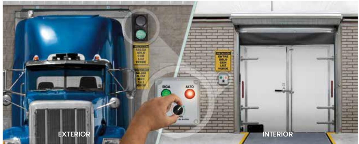
En esta imagen se muestra la posición de instalación de los 3 Letreros de Seguridad.
